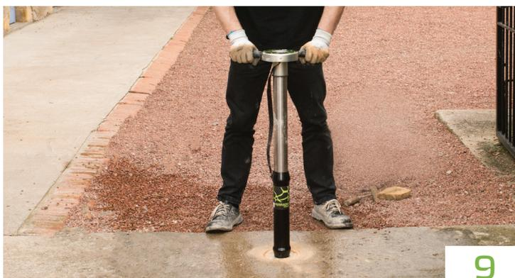
Positionnez la GIRAFE dans le CITY et enfoncez le CITY jusqu'à 1 cm sous la surface du sol.
