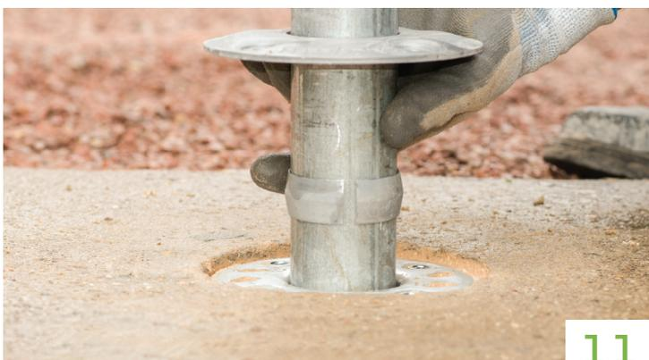
Après avoir enlevé les 4 petits bouchons blancs et graissé les inserts, placez le mât dans le CITY avec la platine et la bague biconique brevetée.
