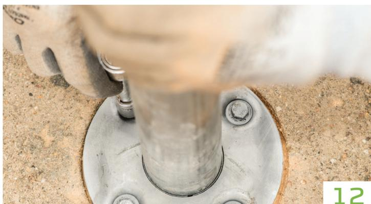
Serrez la platine à l'aide des 4 boulons.
