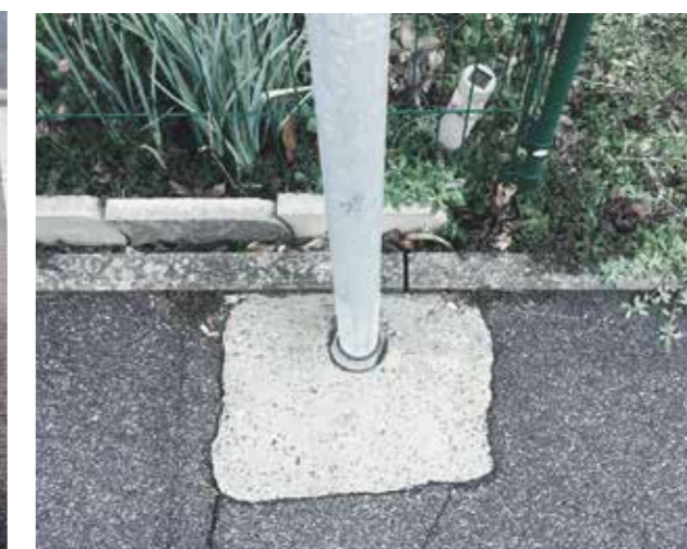
Traditionnel : Manchon coulé dans le béton
