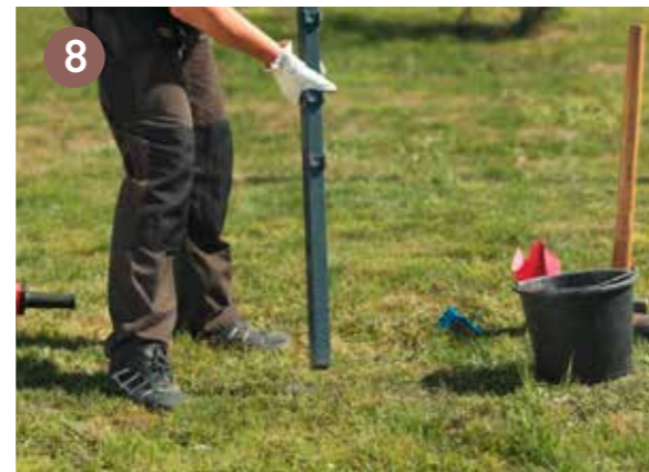
En fonction de la profondeur d'insertion souhaitée du poteau, ajoutez du gravier ou un mélange minéral au Country Rapid
