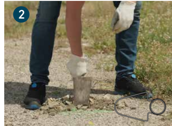
2 Creusez un trou de la taille du support d'environ 10 cm de profondeur.
