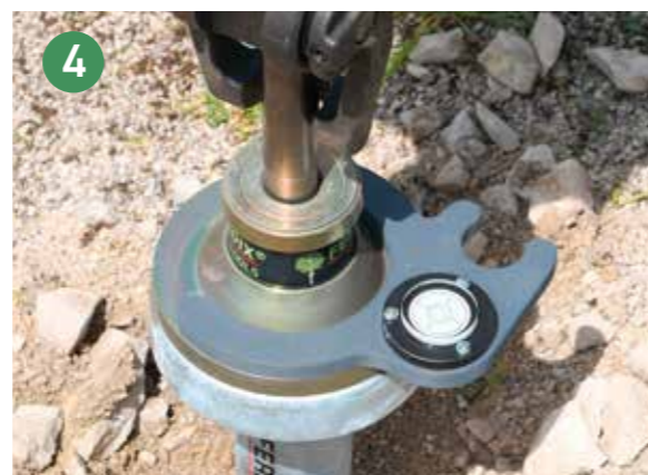
4 Vérifier la position verticale et la corriger si nécessaire lors du pilonnage ultérieur.
