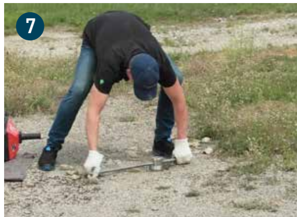
7 Tirez le Rapid tool avec la barre de rotation. Si le sol est argileux, frapper le levier avec un marteau par le côté pour desserrer l'outil au préalable
