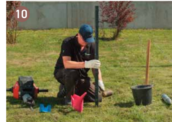
Le grain est compacté en tapotant doucement le poteau avec un maillet en caoutchouc
