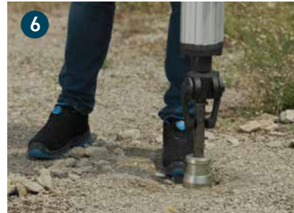
6 Assurez-vous d'enfoncer au niveau du sol ou plus profondément
