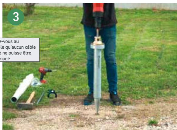
3 Montage et début du processus de battage avec un marteau piqueur approprié (> 50 joules).
