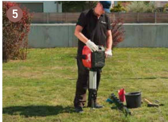
Enfoncez complètement le Pieu dans le sol (compactage)
