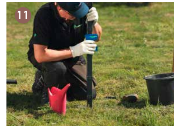
L'assemblage du poteau de clôture est terminé au bout de quelques minutes seulement. Les poteaux de clôture peuvent être chargés immédiatement !
