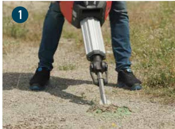
1 Brisez la zone du banquet avec un ciseau plat.
