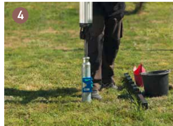
Vérifiez la position verticale et la corriger si nécessaire lors du pilonnage ultérieur
