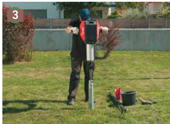
Montage et début du processus de battage avec un marteau piqueur approprié (> 50 joules)
