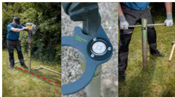
1 Technique des Pose Ferradix® Country
