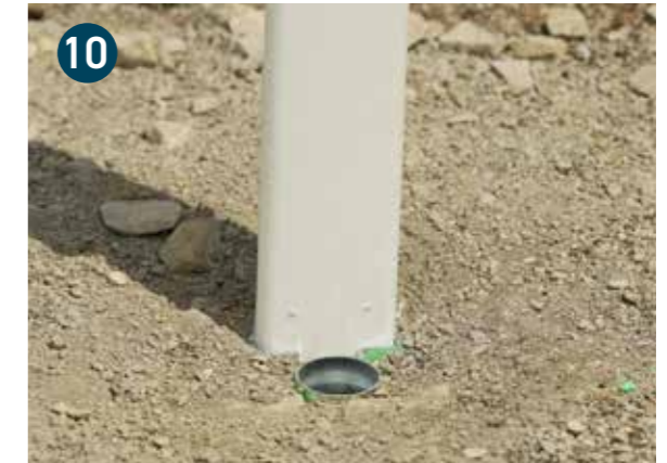
10 Insérez le délineateur dans le support
