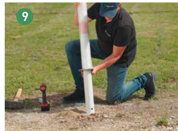
9 Insérez le tube du panneau dans le pieu FERRADIX® Beta.
