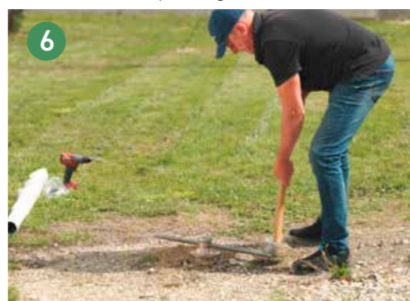
6 Desserrez l'outil Beta avec 1 à 2 coups de marteau latéraux sur le levier.
