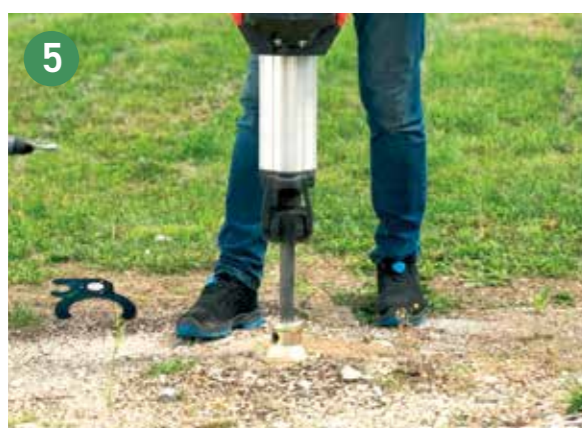
5 Enfoncez complètement la partie supérieure de la cloche du Pieu dans le sol (compactage).
