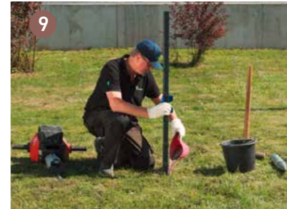
Remplissez tous les côtés de gravier de granulométrie 1 à 5 mm, en vérifiant constamment la verticalité.
