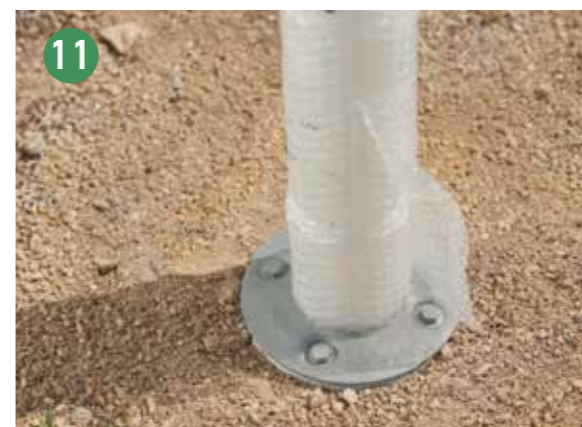
11 La pose du potelet est en quelques minutes achevée.
