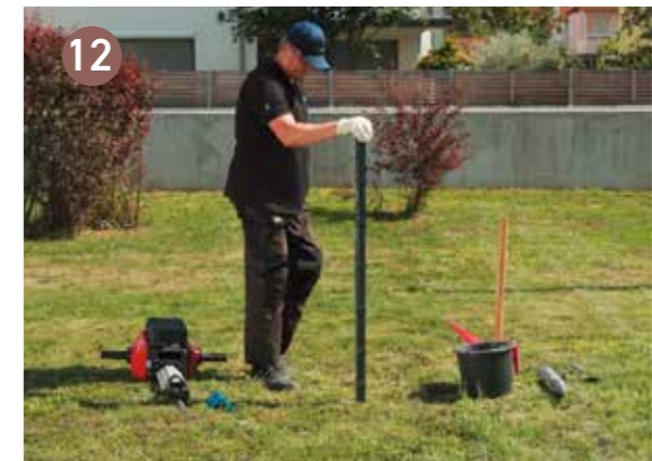
Tendez le cordon et utilisez un gabarit pour déterminer le prochain point d'assemblage.
