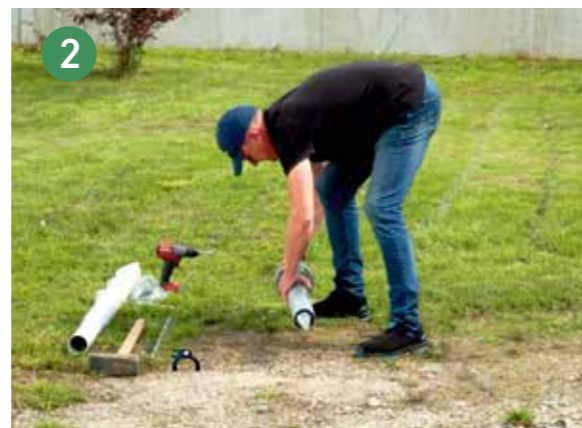
2 Insérez l'outil de Battage „Beta -Tool“ dans le pieu Ferradix® Beta.
