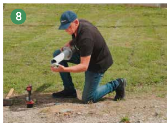
8 Glissez la platine de serrage puis la bague biconique dans le tube du panneau.
