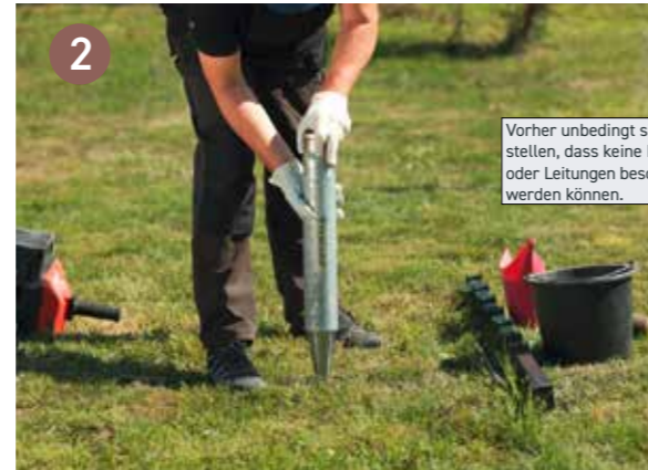
Insérez l'outil de Battage „Rapid-Tool“ dans le pieu Ferradix® Country Rapid.
