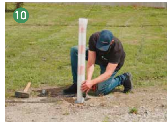
10 Retirez les capuchons de protection des filetages, graissez les inserts et vissez-les fermement.
