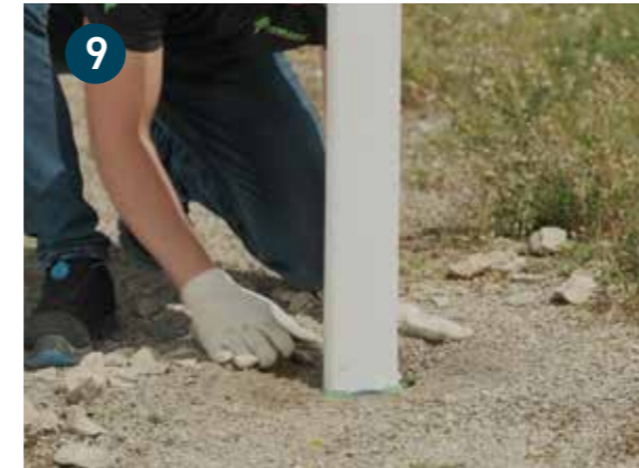
9 Remettez et compactez la terre sur le côté du support
