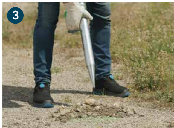
3 Insérez le « Rapid-Tool » avec pointe dans le tube du support
