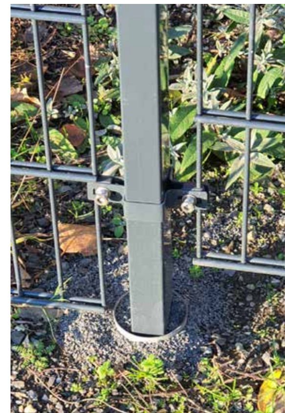
seulement du gravier - pas de béton
