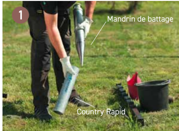
Matériel de travail (poteaux de clôture 60x40 mm et gravier), outils et pieux
